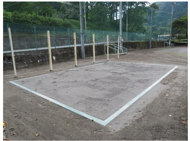
▲ 完成した砂場：安心して走り幅跳びができます
