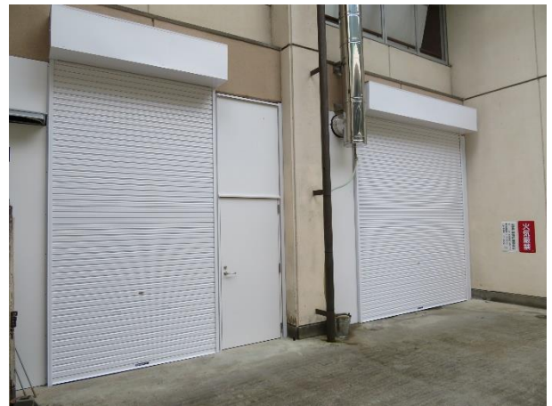
▲ 完成したペレットボイラー前のシャッター扉
